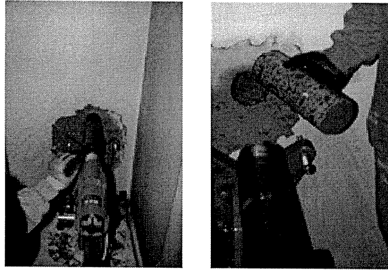
Şekil 18. 3. Oda kattaki betonarme perdesinden alınan karot numunesi
